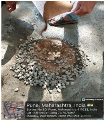
FIG.3.4. A.1 CONCRETE MIX
