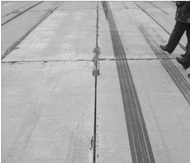
Figure-8. PAG precast airfield slab
